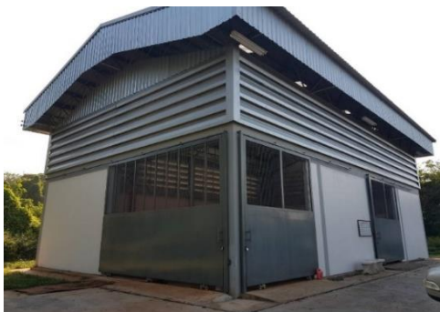
รูปที่ 18 ลักษณะอาคารคลังเก็บสารปนหลง คลังแบบที่ 5
