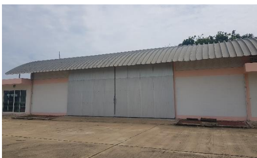
รูปที่ 20 ลักษณะอาคารคลังเก็บสารปนหลง คลังแบบที่ 6
